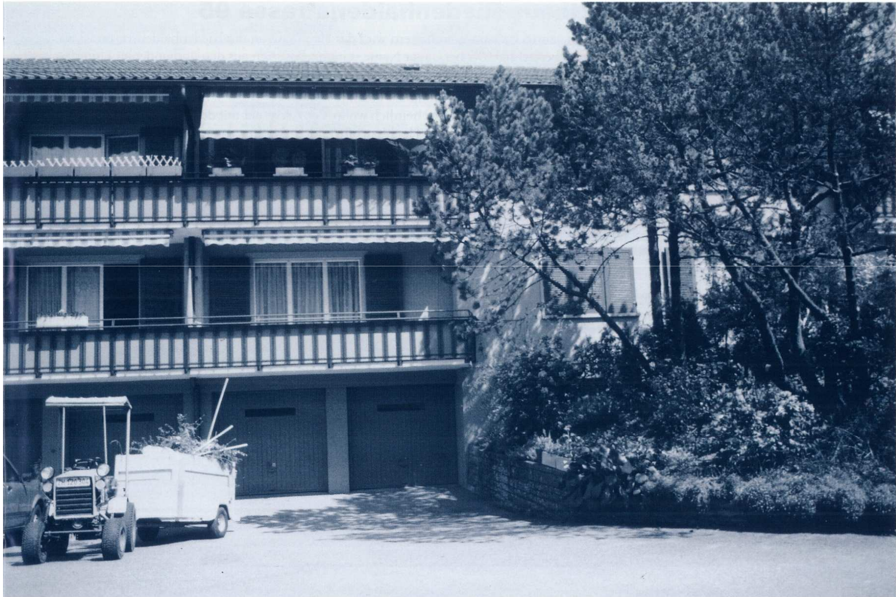
Überbauung In Böden mit Hauswartgaragen
