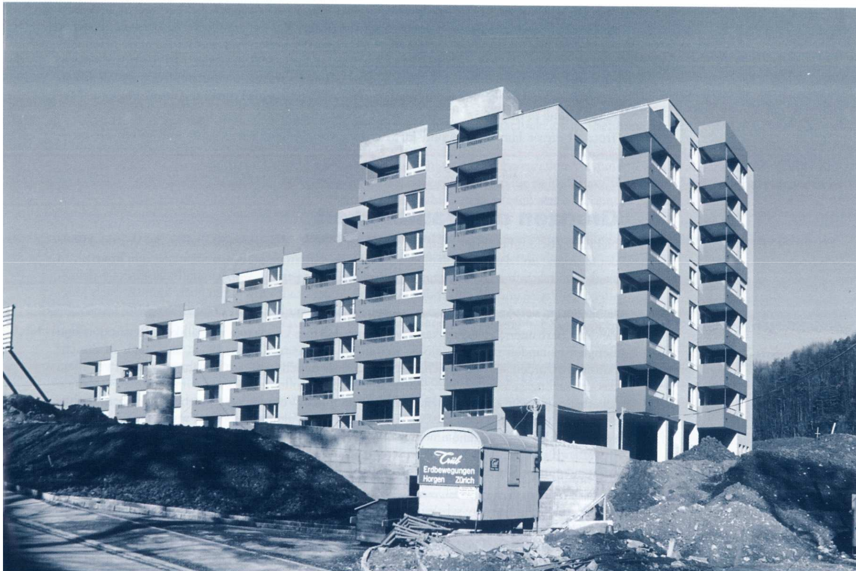
Überbauung Finsterrütistrasse, Adliswil, 11. Etappe, während der Bauzeit
