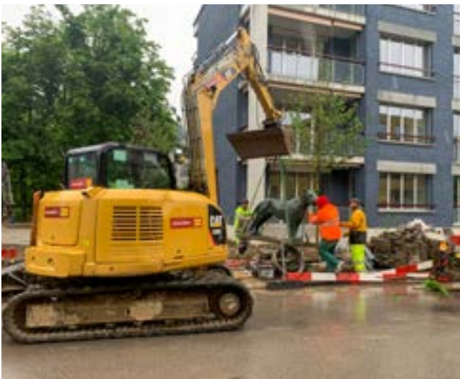
Die Löwin wird an den neuen Ort gehievt.
