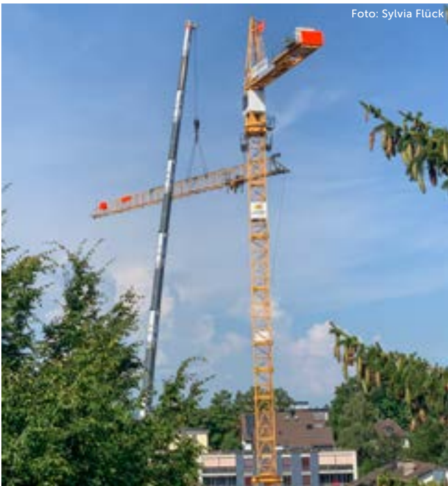
Am 12. August wurde der erste Kran für die dritte Neubauetappe in spektakulärer Höhe mittels eines Auslegers (links) aufgestellt.
