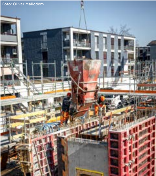
Betonieren für den Neubau.
